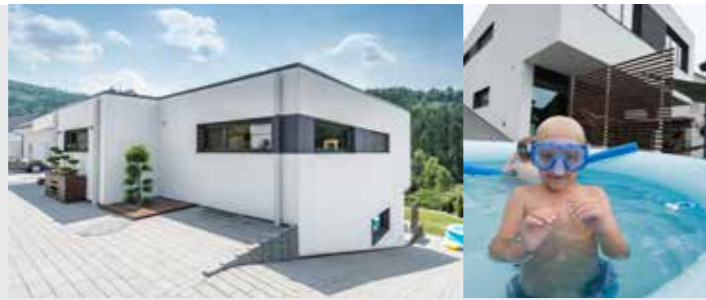
Das Haus wurde optimal auf das Hanggrundstück angepasst.
